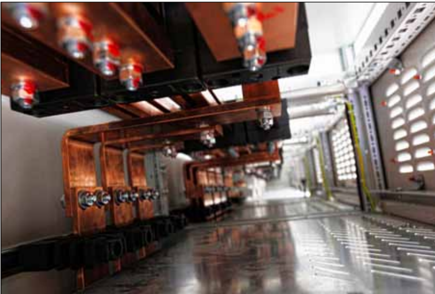
Statt aufwendiger Verkabelung im Bodenbereich: Die Energieverteilung auf die einzelnen Schaltanlagen übernimmt das im Containerdach geführte Stromschiensystem Maxi-PLS von Rittal.
